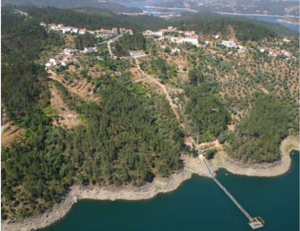
Captação da Cabeça Gorda na Albufeira do Castelo do Bode (vista panorâmica)
