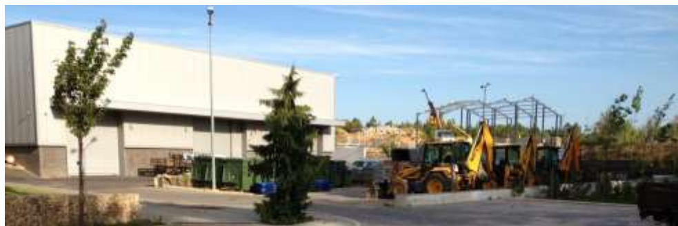
Vista parcial da zona de armazém e parque de máquinas. Em segundo plano, as obras para o novo armazém e estação de lavagem de viaturas.
