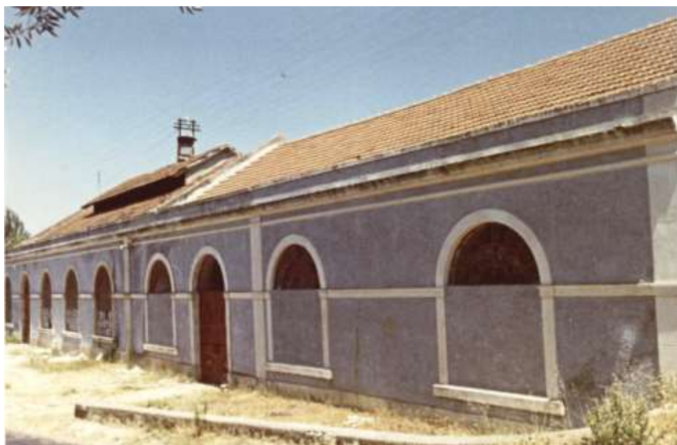
Central de Vale de Rãs em julho de 1968, já sem atividade, servindo como simples armazém. (Fonte: Arquivo Municipal)
