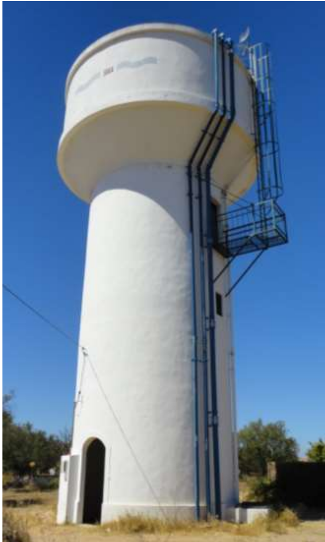
Reservatório Elevado do Pego
