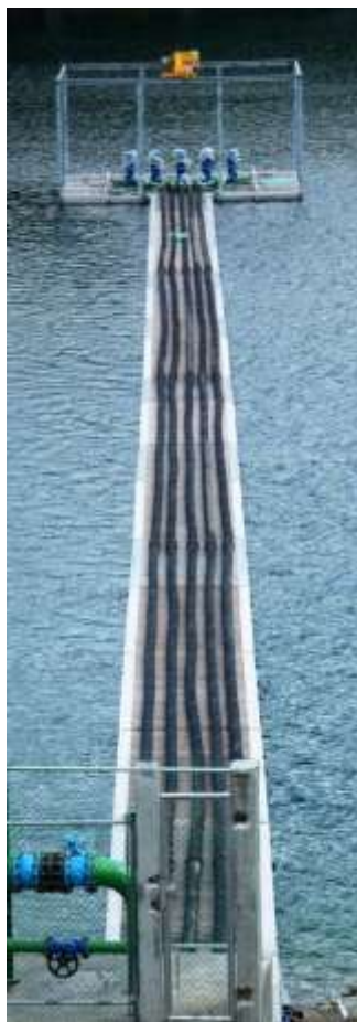
Captação da Cabeça Gorda (pormenor)
