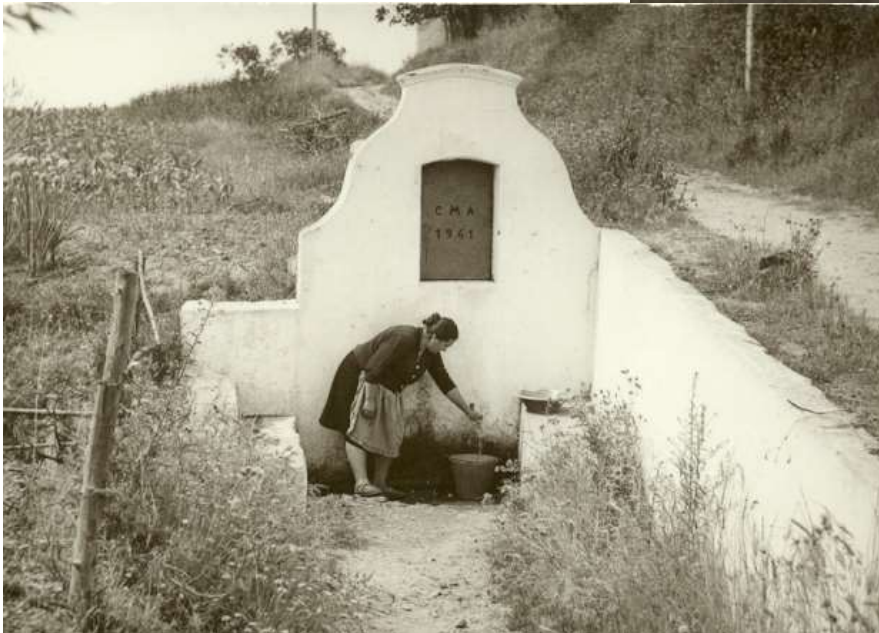
Martinchel: antigo reservatório e fontanário (Fonte: Arquivo Municipal)
