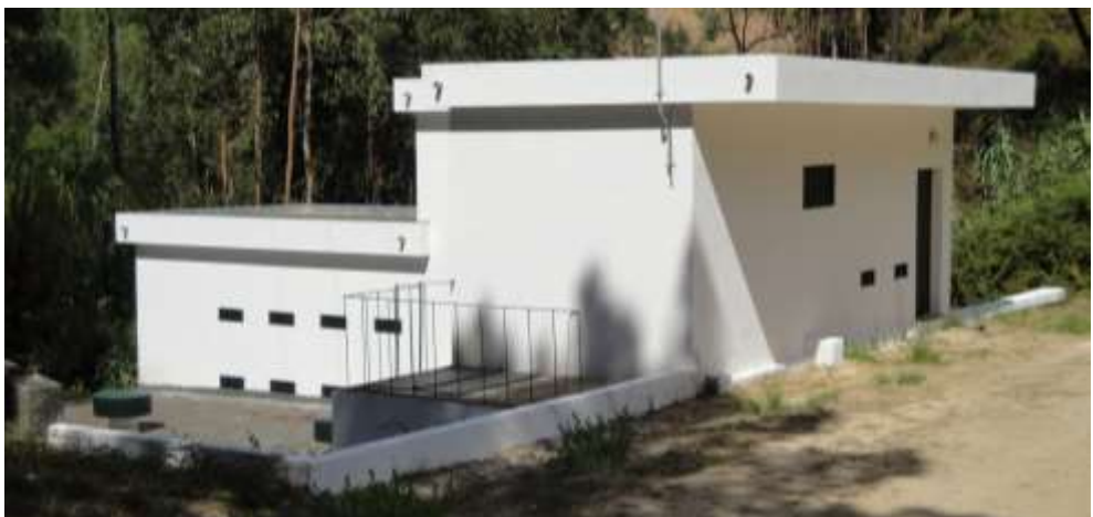
ETA da Bouça que serve o sistema do Souto
